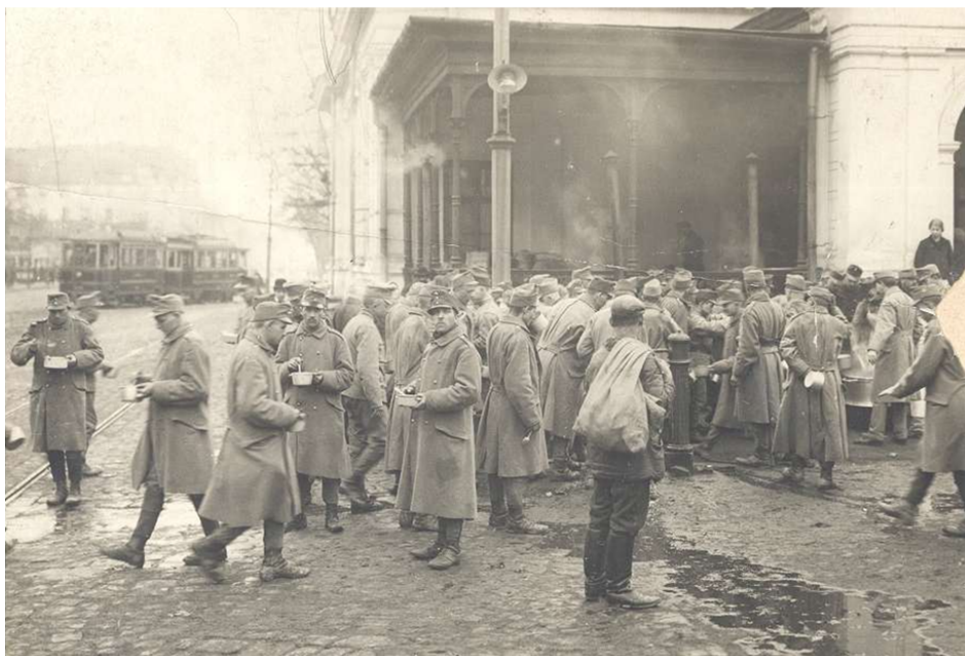
Az I. világháború végével a hazatérő katonák számára népkonyhát nyitottak az épületben. (Forrás: Hungaricana)
